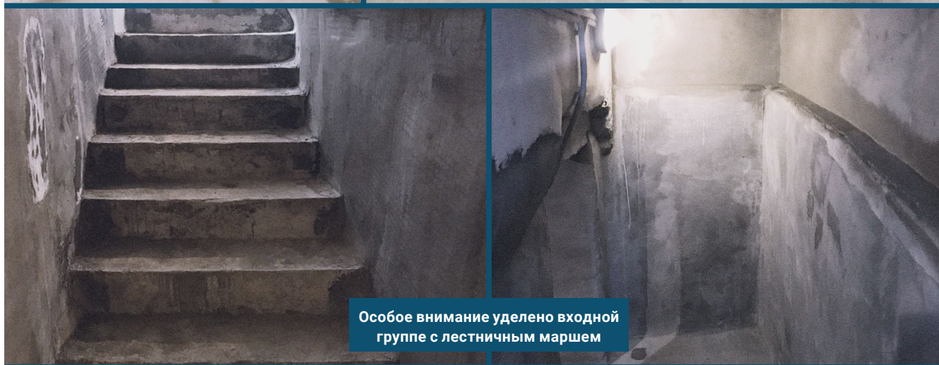
Техническое помещение планетария до и после работ
